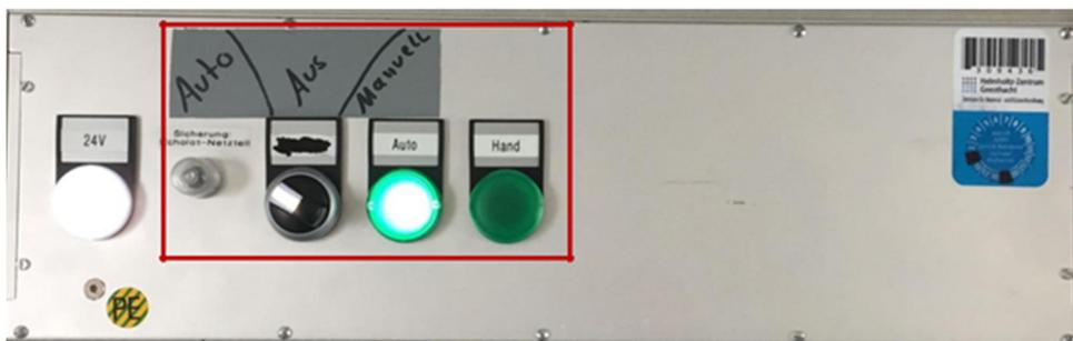
Abb. 7: Wahlschalter am ADCP Netzteil, Positionen von links nach rechts: AUTO – AUS – MANUELL
